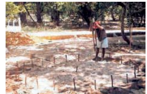
Primer día de la construcción Determinar los puntos alrededor del centro. 24 palos largos son la base de la construcción..
