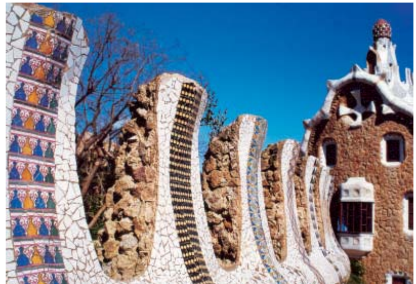
Detalle del muro
