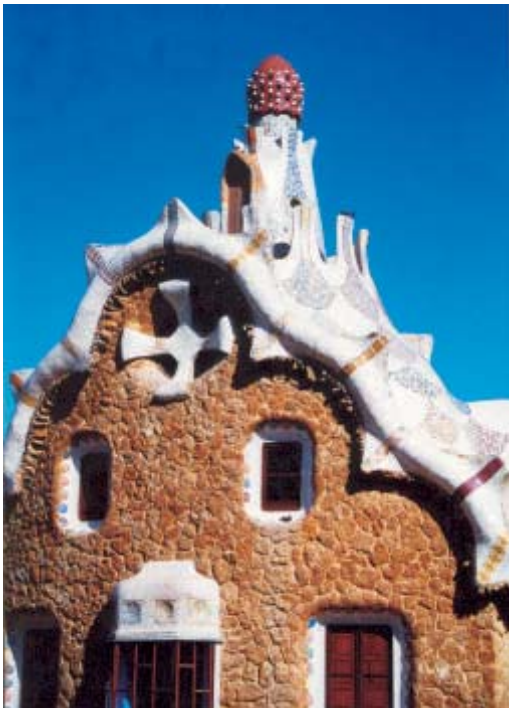
Casa del conserje (detalle de la chimenea)
