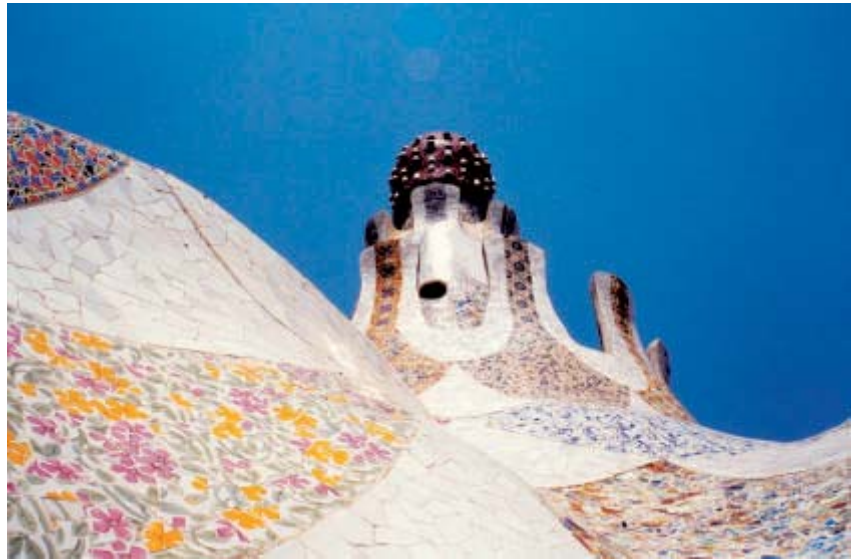
Detalle del tejado de la casa el conserje
